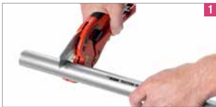
Boru uzunluğunun təyin edilməsi
